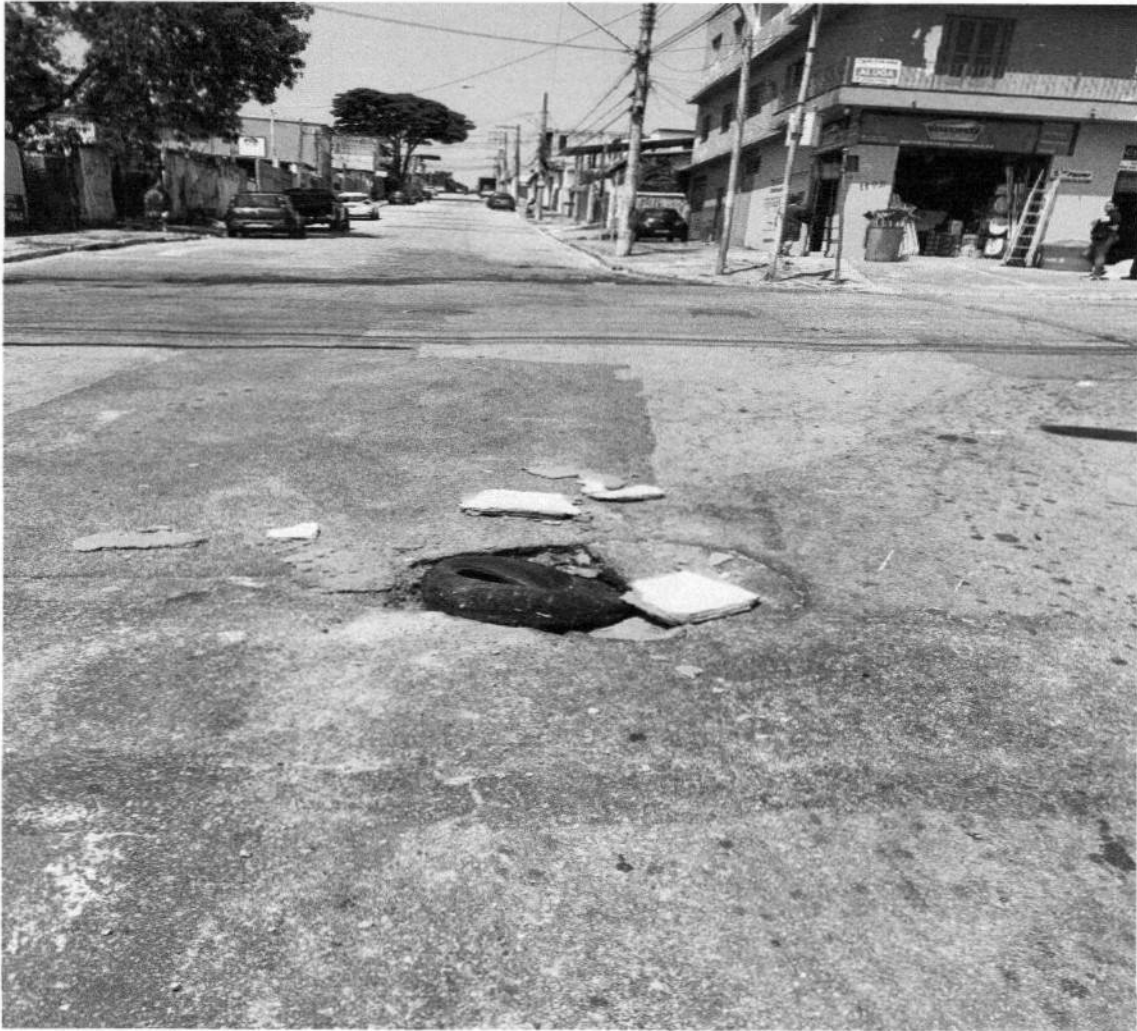
MANUTENÇÃO ASFÁLTICA NO CRUZAMENTO DA RUA MÁRIO YOSHIDA COM A AVENIDA ALEXANDRINA DE PAULA, BRÁS CUBAS – MOGI DAS CRUZES.
